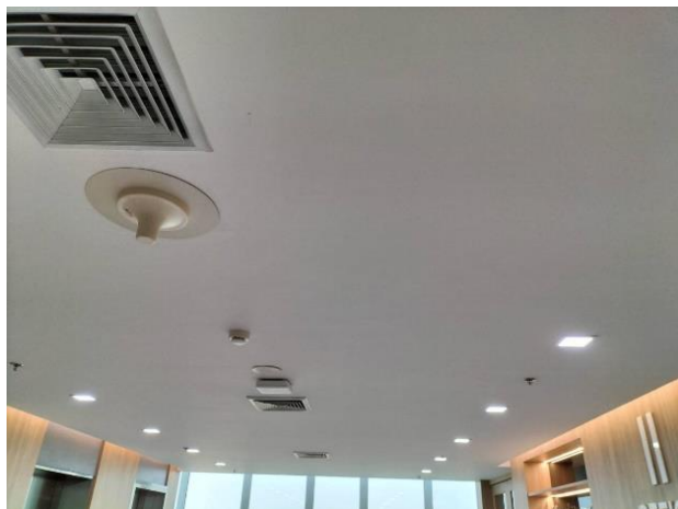
รูปที่ 2-26 ติดตั้งหลอดไฟ LED บริเวณพื้นที่ส่วนกลางและภายในห้องผู้ป่วยทุกห้อง
