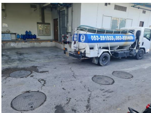
รูปที่ 2-13 การสูบน้ำก่อนบ่อน้ำบาดน้ำเสีย
