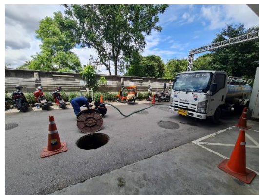
รูปที่ 2-13 การสูบน้ำก่อนบ่อน้ำบาดน้ำเสีย
