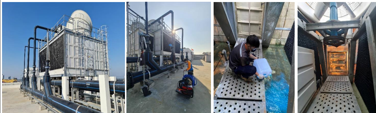
รูปที่ 2-43 ผนังล้อมรอบด้านข้างเหนืออ่างรองรับน้ำในห้องฝังเย็น เพื่อลดการฟุ้งกระจายของละอองไอน้ำที่ปลิวออกมา
